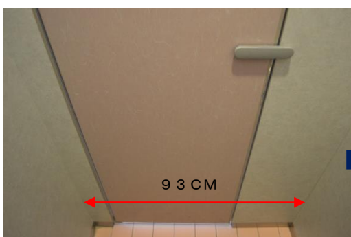
改修前の扉位置
