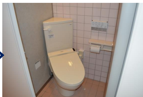
改修後の洋式トイレ
