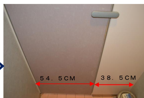
改修後の扉位置
