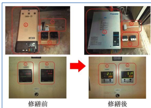
写真5 空調設備湿度制御機器の修繕
