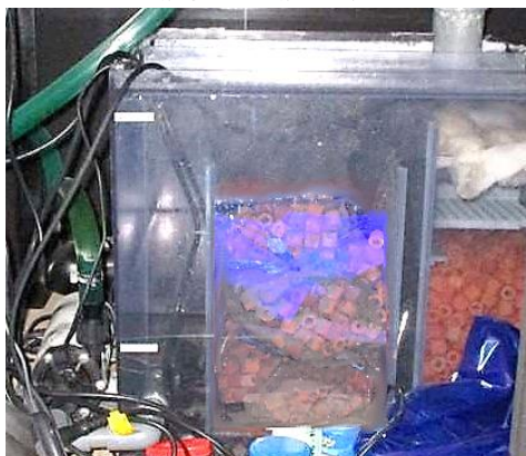
写真2. 円形水槽②のろ過槽（改善前）
