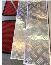
写真2 階段の滑り止め
