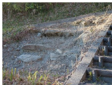
写真3. 整備後の露頭の様子（令和6年12月17日撮影）
