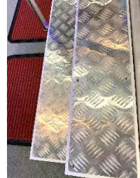
写真2 階段の滑り止め
