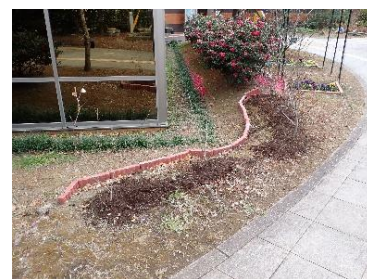
写真6 ブロックでの土留め
